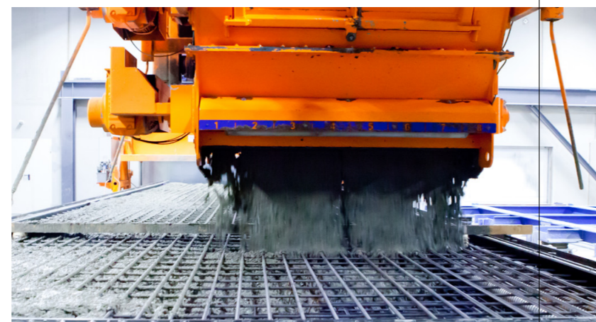
Bild: Halbautomatischer Beton- und Rütteltisch, WUA bei FBW in Dormettingen
