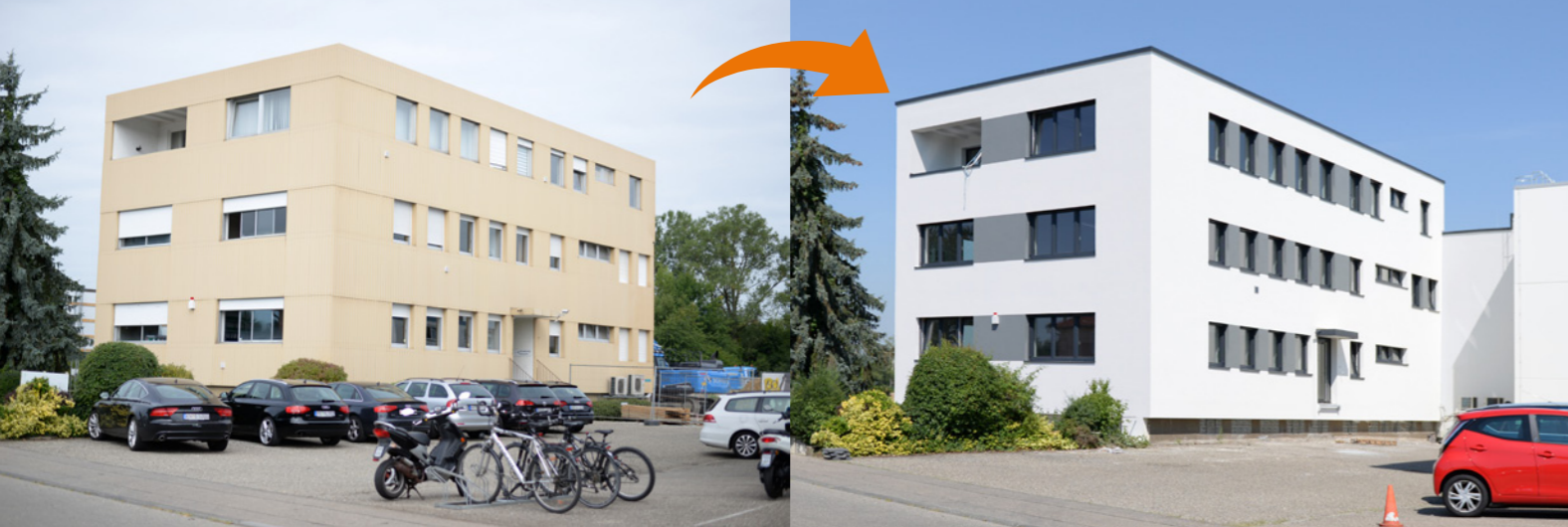
Vorher-Nacher-Fotos: Beispiel für eine Bürogebäudesanierung 2021 in Rielasingen-Worblingen
