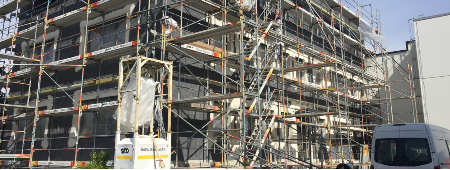
Foto: Sanierungsmaßnahmen bei der Firma ELGO in Rielasingen-Worblingen 2021
