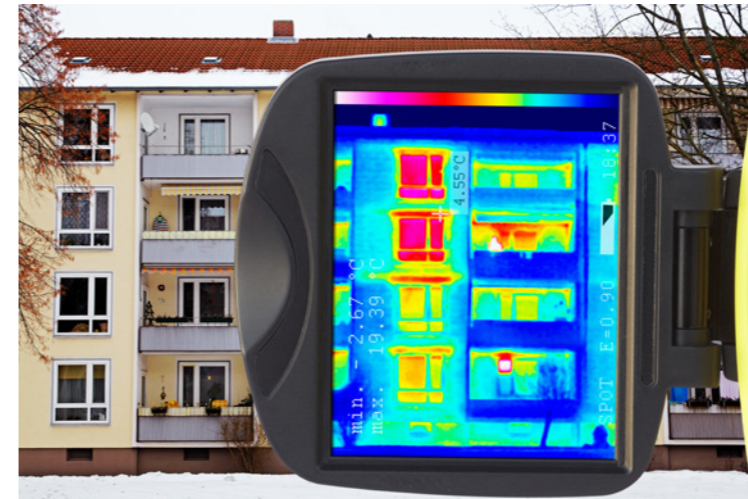
Foto: Die Wärmebildkamera offenbart, wo am meisten Energie verloren geht
