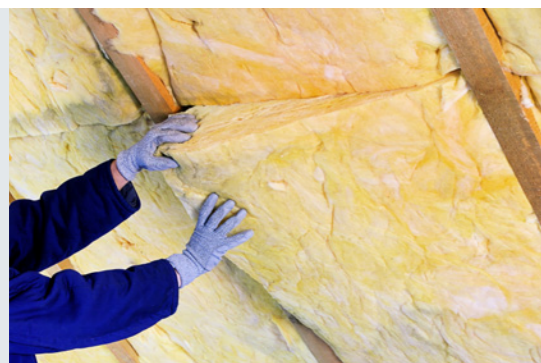
Foto: Zwischensparren-Mineralwolle-Dämmung
