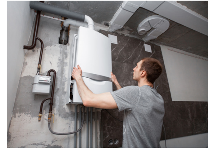
Foto: Montage Gasbrennwertheizung
