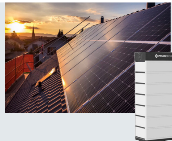
Foto: Photovoltaikanlage mit Batteriespeicher
