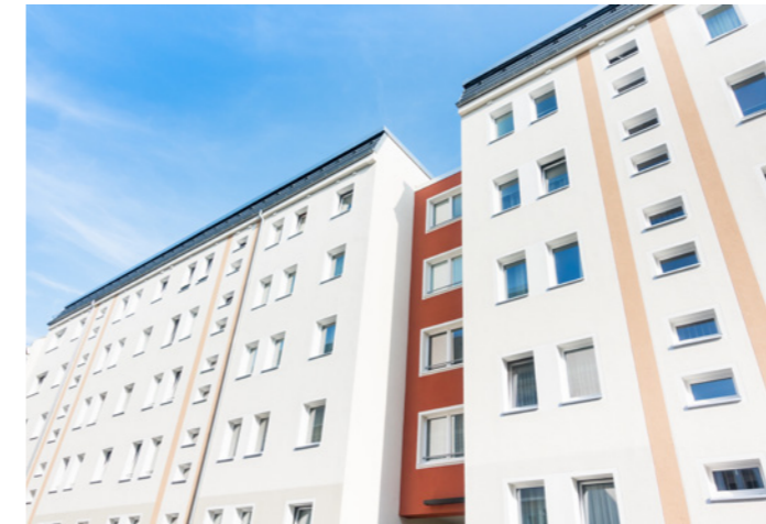
Foto: Beispiel umfänglich saniertes Wohngebäude Baujahr 1958
