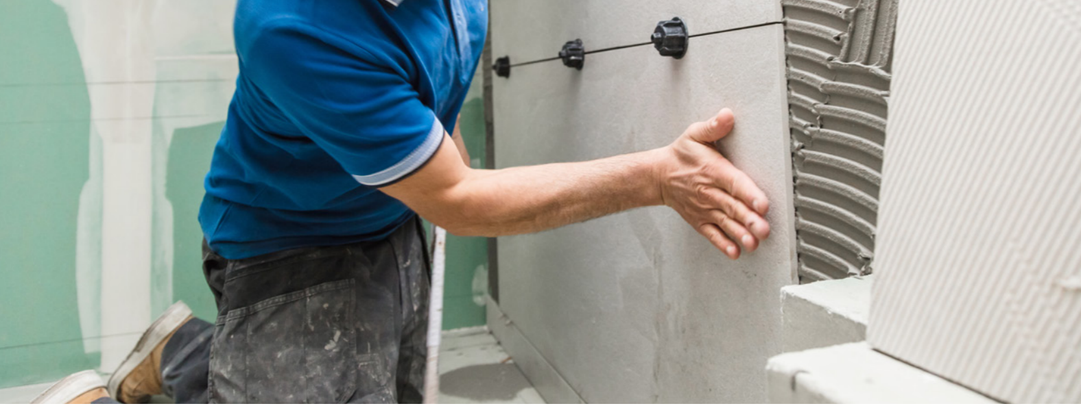
Foto: Fliesenleger beim Innenausbau
