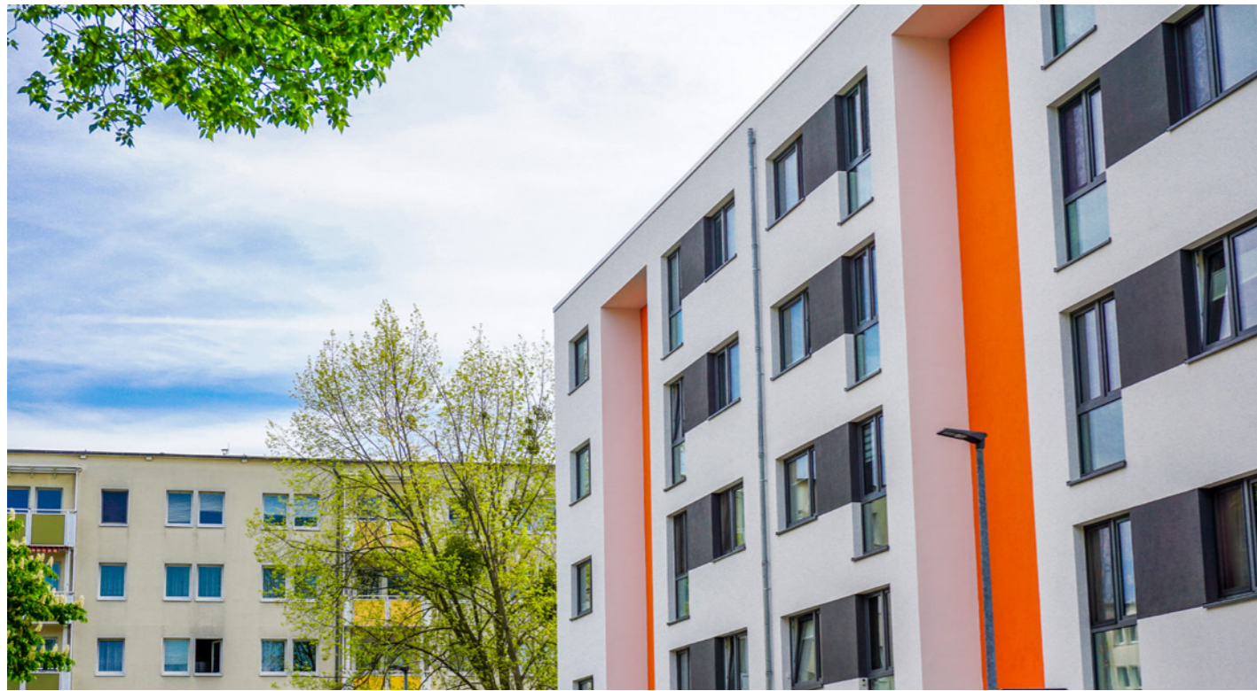
Foto: Gegenüberstellung unsanierter und sanierter Wohnblock aus demselben Baujahr und Wohnquartier
