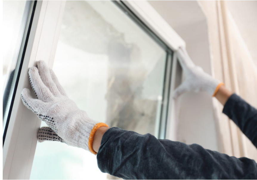
Foto: Einbau neuer moderner Fenster mit 3-fach- oder 4-fach-Verglasung
