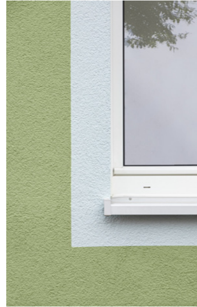
Foto der Sto von Martin Dückel, Ulm: Fachgerechter Einbau mit Fensterbank aus Alu
