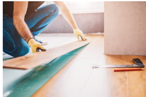
Foto: Verlegung neuer Fußböden
