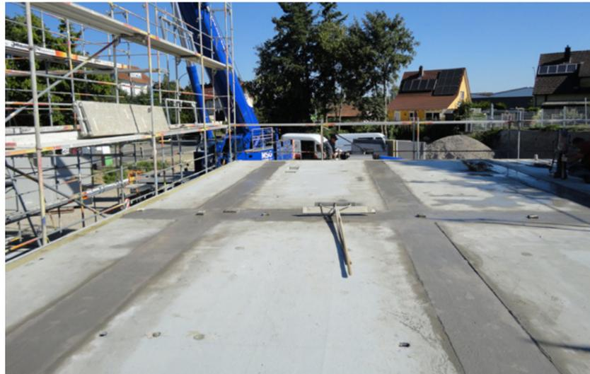
Bild: Frischer Mörtelverguss der Deckenplatten
