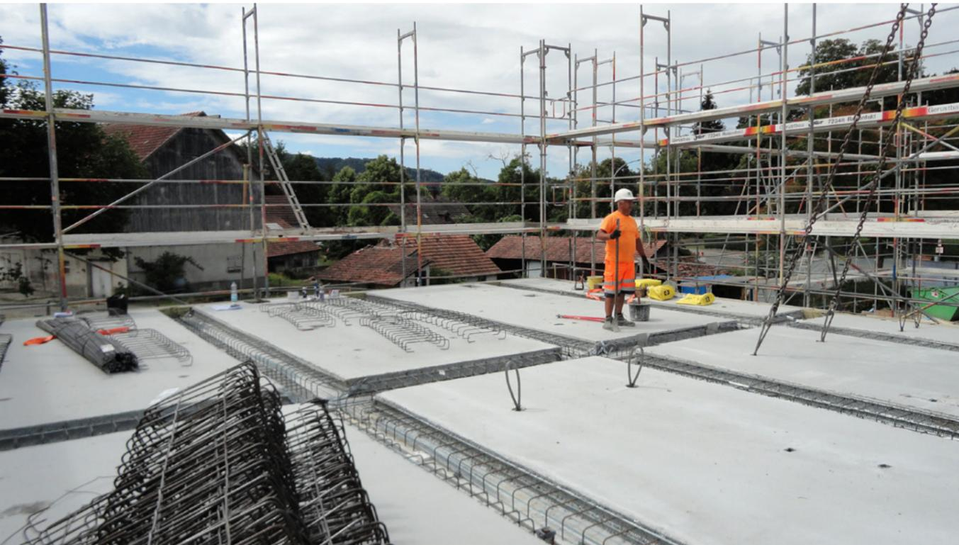
Bild: Verlegung der Deckenplatten beim Bauwohnen in Rielasingen-Worblingen
