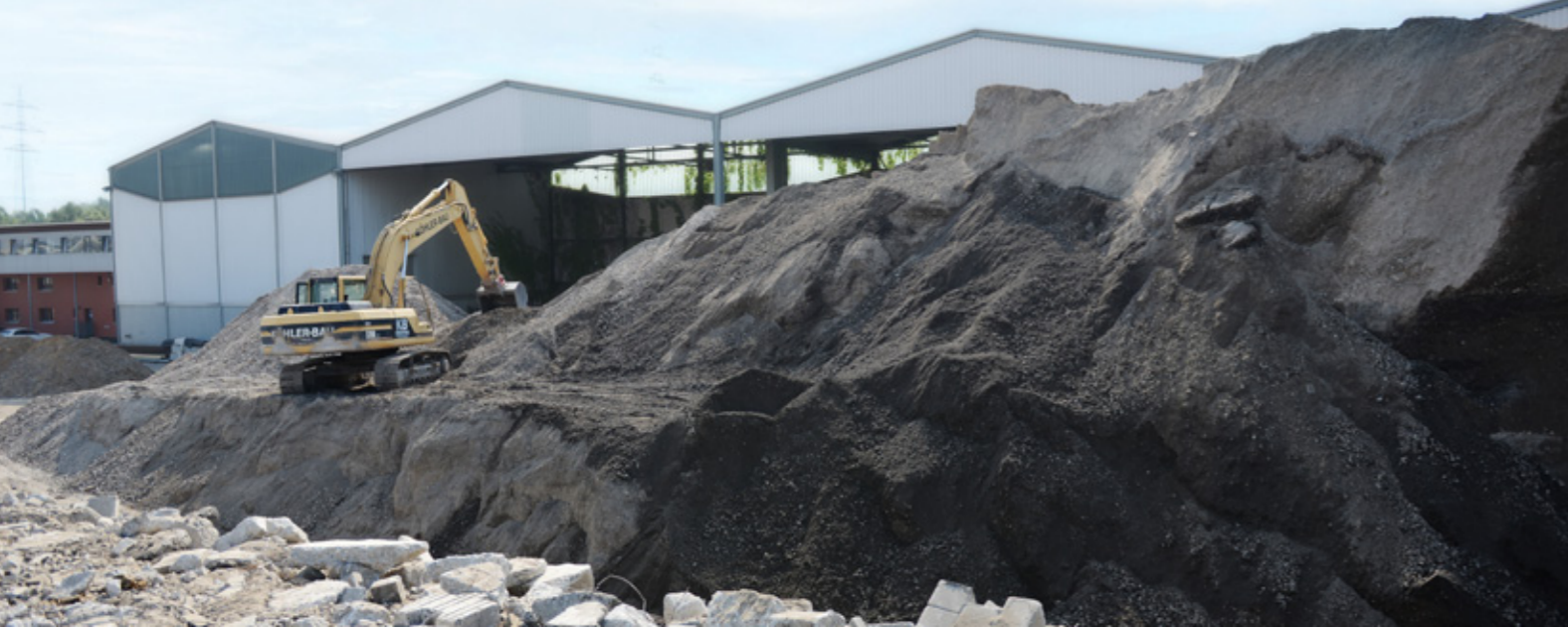
Bild: Zwischenlagerung Straßenaufbruch KB-Werksgelände in Karlsruhe
