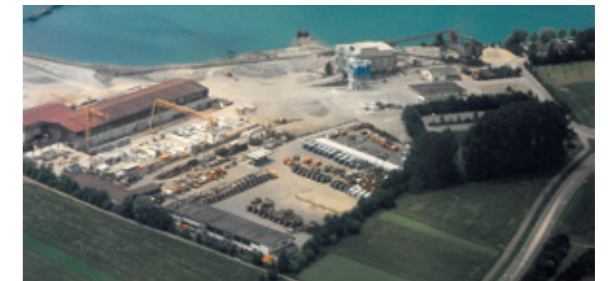
Luftaufnahme Werk Kippenheimweiler mit SBL
