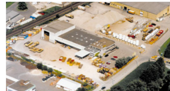
VBE, Erdbau- und Abbruchunternehmung, Eislingen
