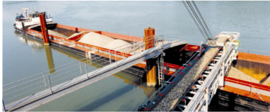
Schiffsverladeanlage Werk Ottenheim
