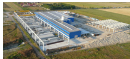
Vogel-Bau Betonfertigteilwerk in Rumänien
