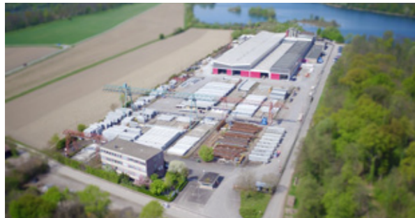
Betonfertigteilwerk Linkenheim (BWL)
