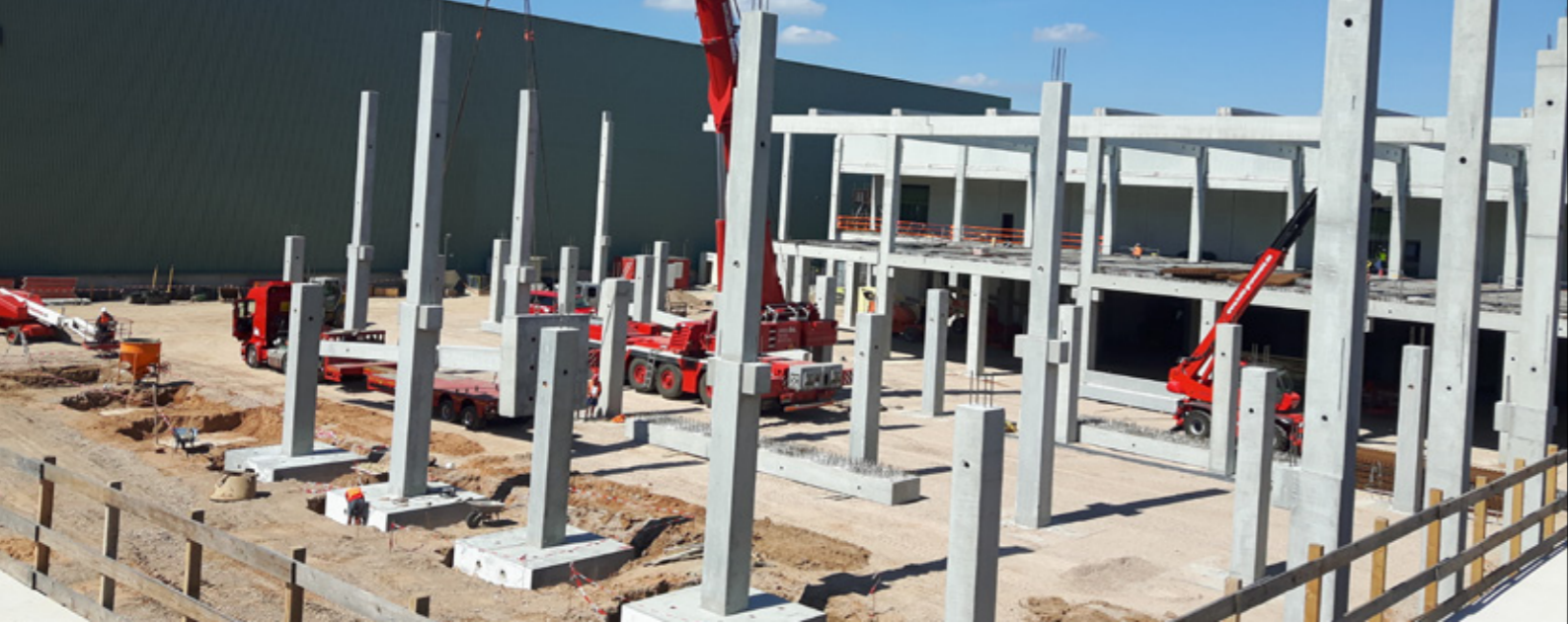
Bild: Fertigteilmontage von KML auf einer Industriebau-Baustelle
