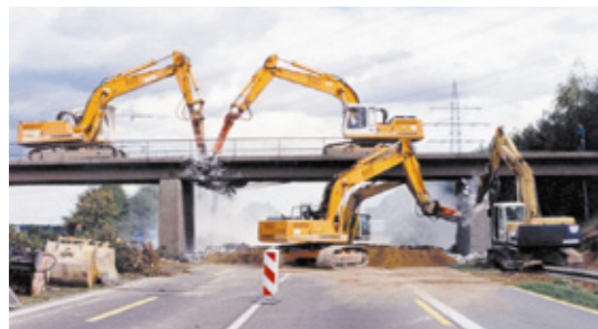
Brückenabbruch durchgeführt von Walther Keune-Bau
