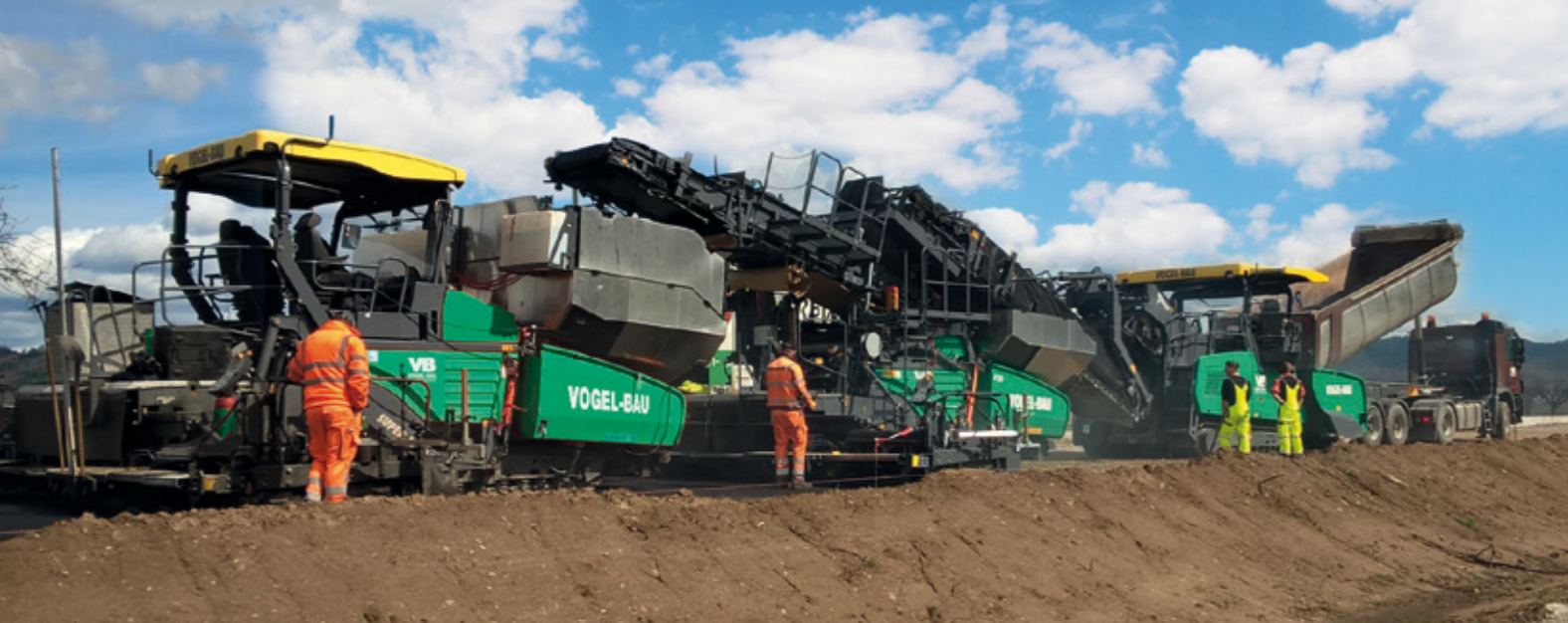
Bild: VOGEL-BAU Autobahn-Asphaltierung
