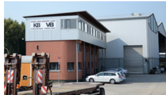
VB-Außenstelle bei Köhler-Bau in Karlsruhe
