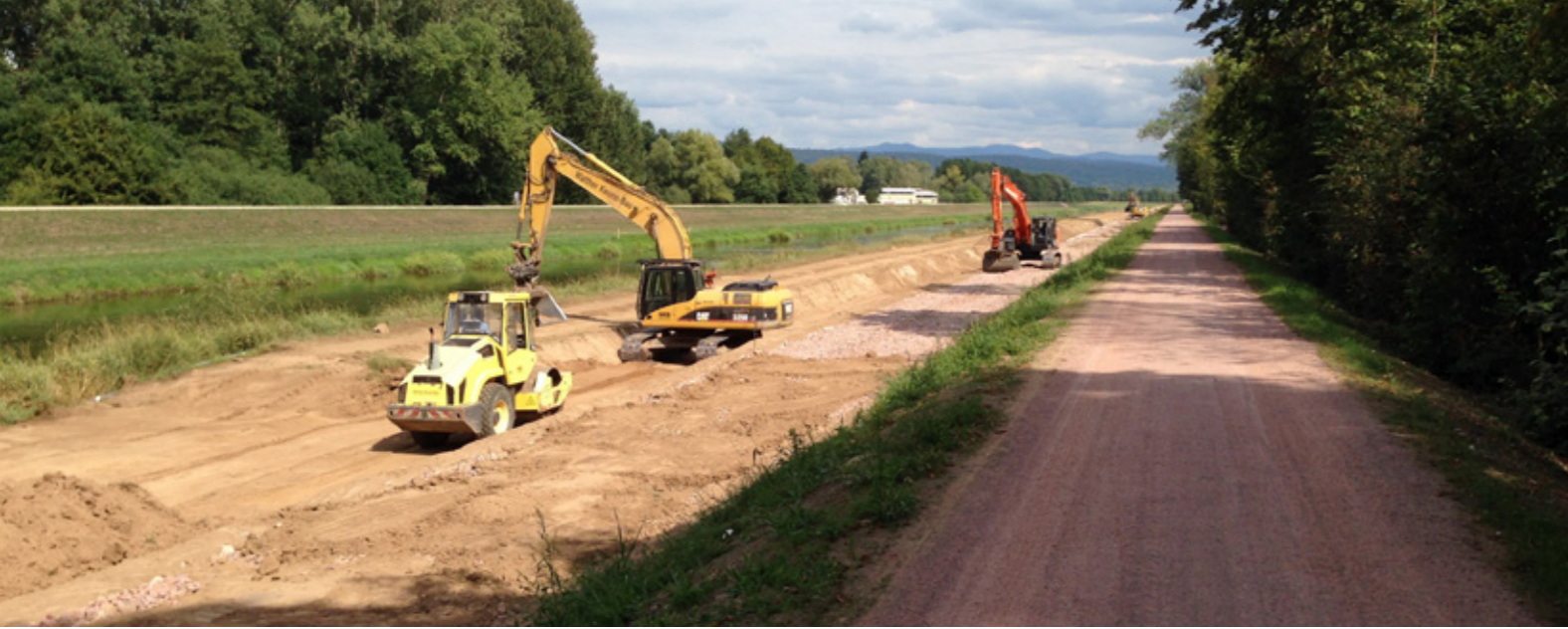
Bild: Elzdamm-Baustelle zwischen Köndringen und Riegel
