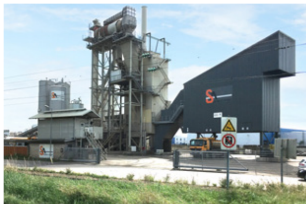
Asphaltmischanlage, Rheinhafen Karlsruhe
