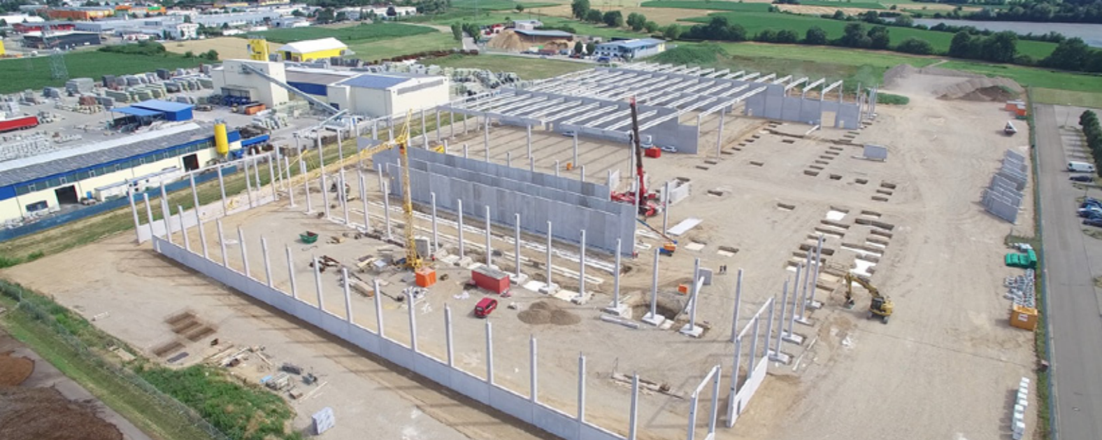
Bild: Industriebau-Baustelle in Herbolzheim
