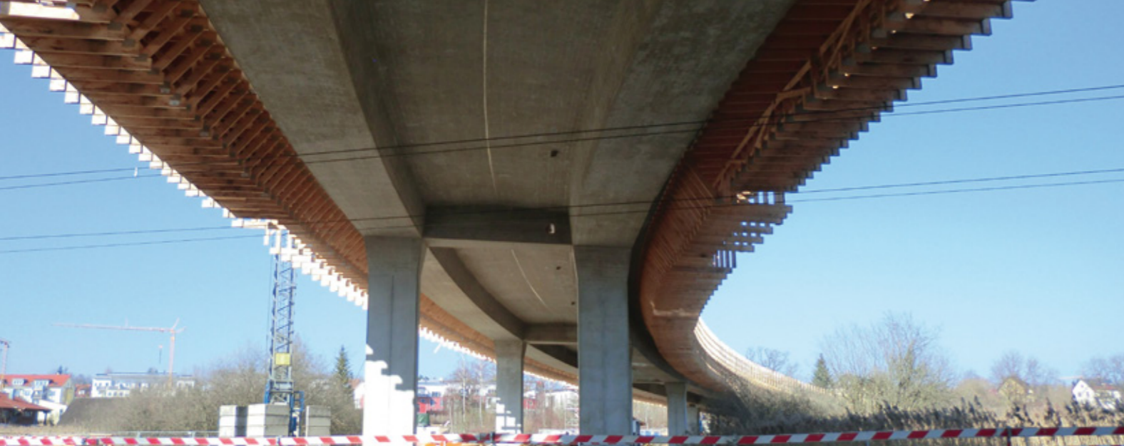
Bild: MB-Brückenbauwerk Kraftfahrzeugstraße L224 bei Konstanz
