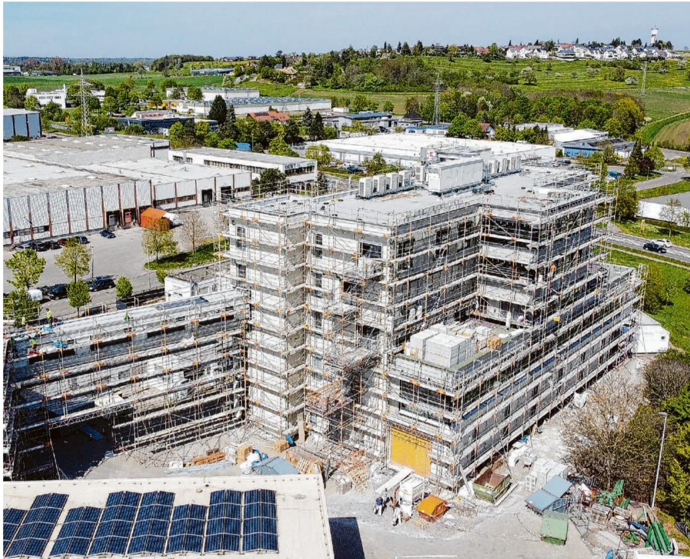
In der Rohbauphase: der Bentley-Neubau „Admin II“. Fertigbau Wochner hat als Generalunternehmer vielfältige Herausforderungen bewältigt. Foto: Fertigbau Wochner
