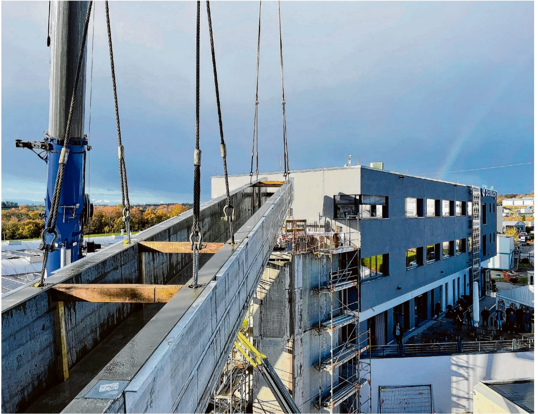
Die 24 Meter lange und 54 Tonnen schwere Verbindungsbrücke zwischen dem Bestandsgebäude „Admin I“ und dem Neubau „Admin II“ wurde in einer aufsehenerregenden Aktion mit gleich zwei schweren Mobilkränen vorsichtig in Position gebracht. Foto: Fertigbau Wochner
