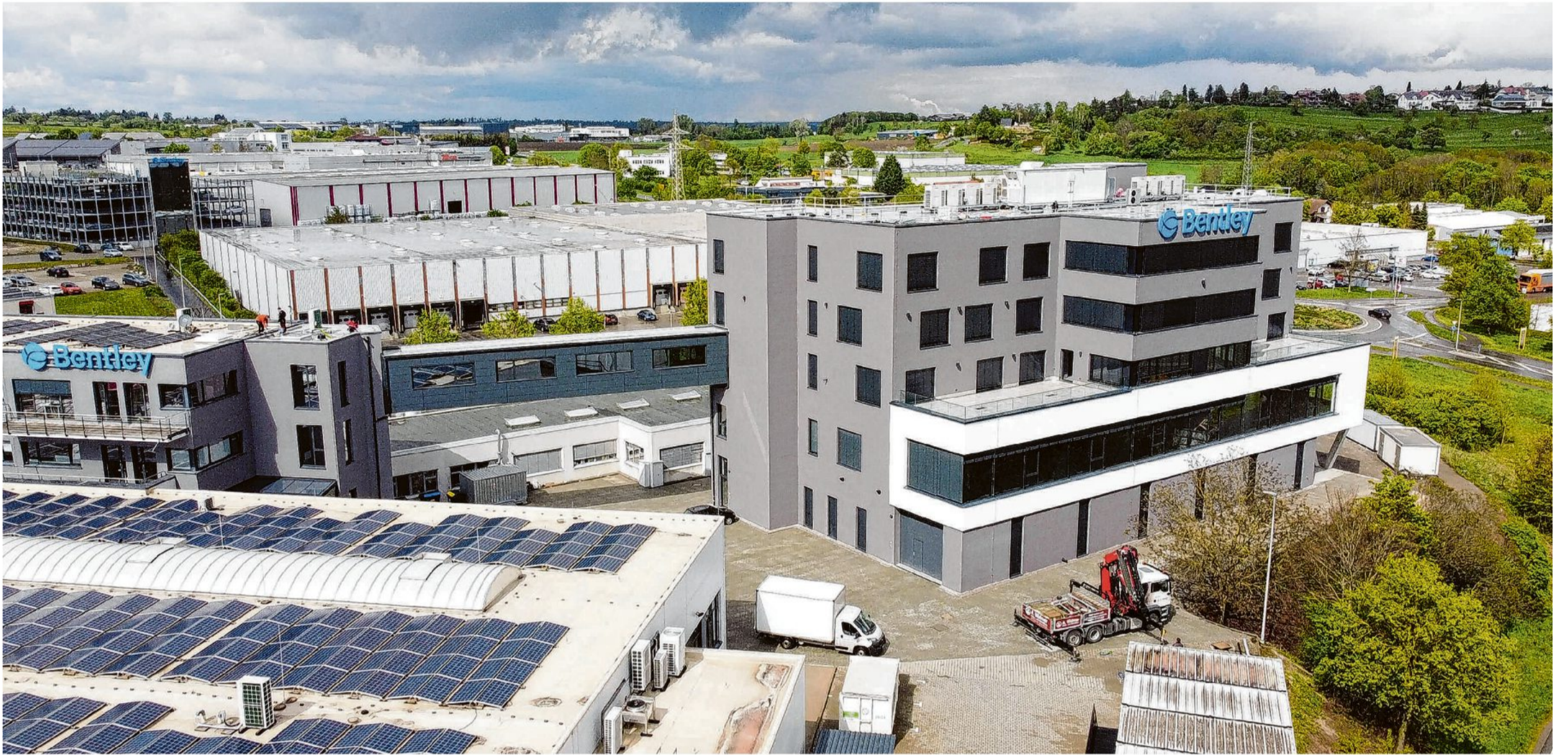
Aus der Vogelperspektive: der Bentley-Neubau „Admin II“ (rechts), perfekt angedockt an das Bestandsgebäude.
