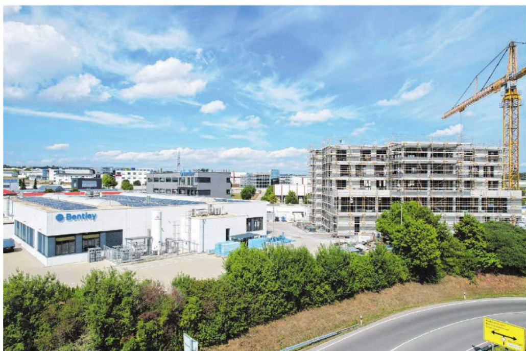
Die Baustelle bei Bentley: Der Neubau fällt um einiges höher aus (rechts) als die bisherigen Bentley-Bestandsgebäude, inklusive des Parkhauses. Foto: Bentley
