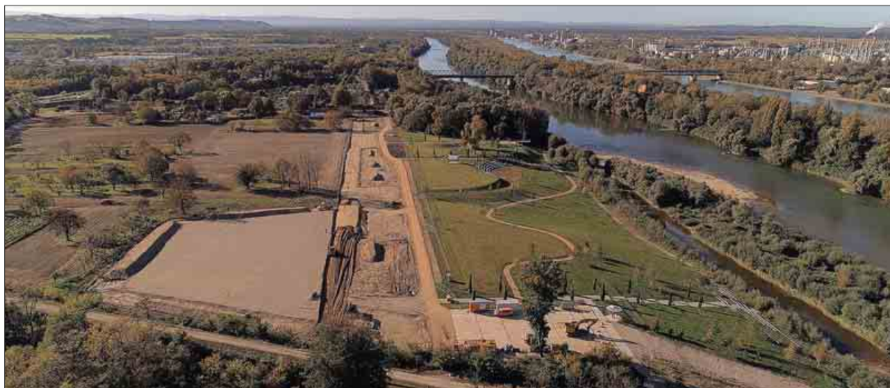
Die Bauarbeiten auf dem künftigen Landesgartenschau Gelände in Neuenburg schreiten voran.
